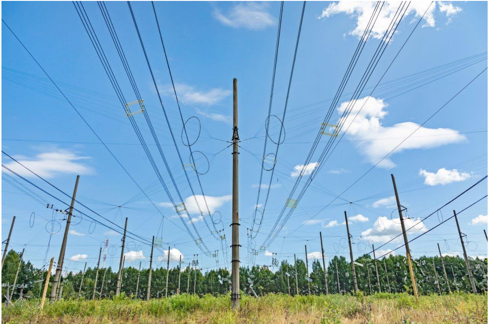
Антенное поле стенда СУРА 300x300 м2.
